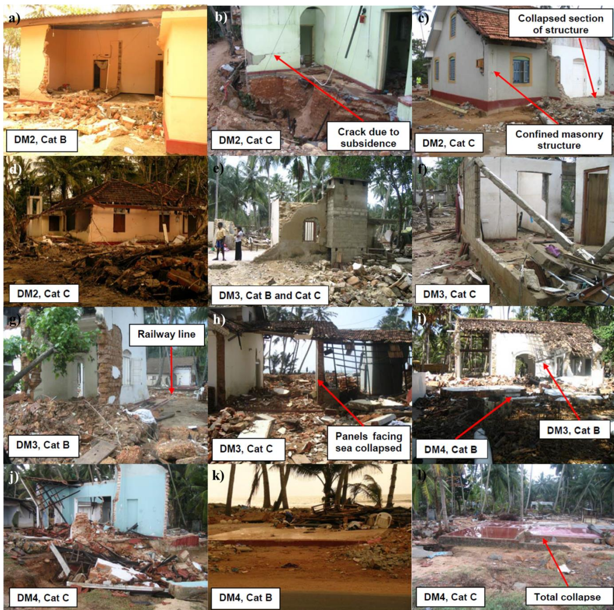
Abb. 5.7: Zerstörung von Mauerwerksgebäuden in Sri Lanka (Pomonis, et al., 2006): a) Paiyagala, b) Kahawa, c) Kahawa, d) Peraliya, e) Peraliya, f) Peraliya, g) Paiyagala, h) Paiyagala, i) Unawatuna, j) Kahawa, k) Paiyagala, l) Kahawa
