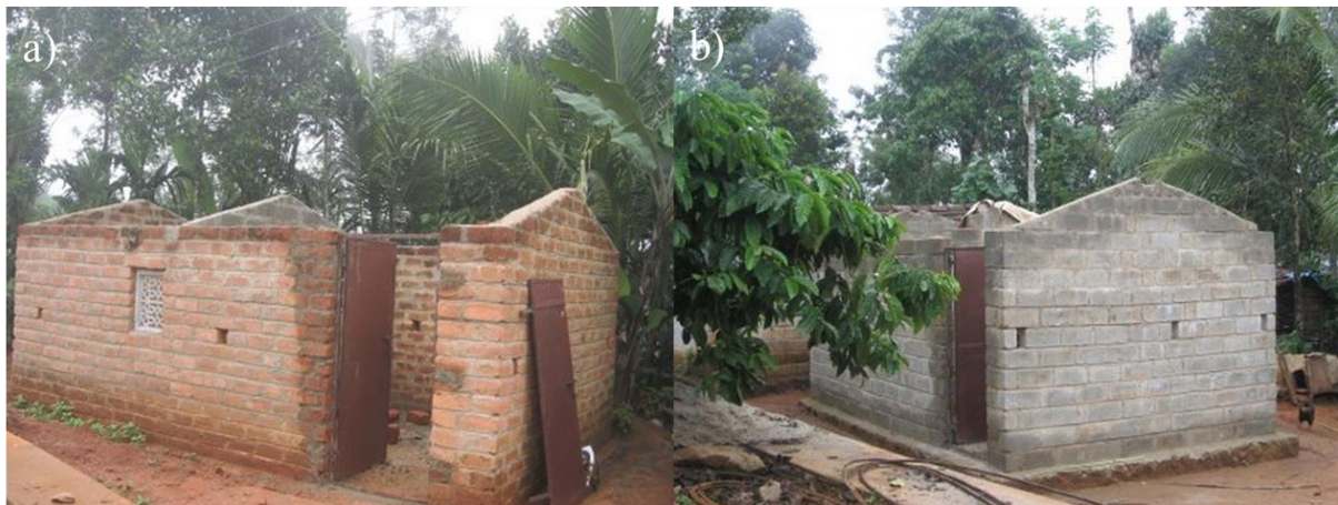
Abb. 3.8: Ziegelsteine in Indien (Internetquelle 26): a) sonnengetrocknete Ziegelsteine, b) gebrannte Ziegel und Zementblöcke
