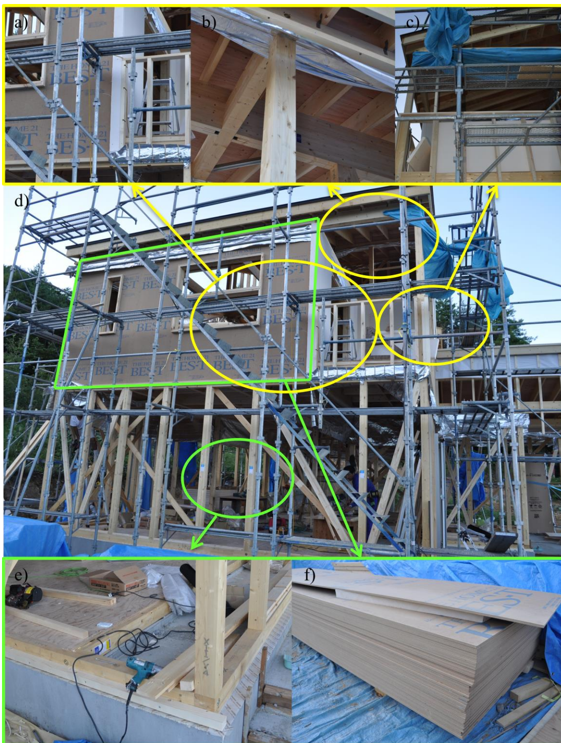
Abb. 3.3: Fortgeschrittener Hausbau bei Miyako, Japan: a), b) und c) Dachgiebel mit oberer Beplankung, d) Gesamtansicht des Rohbaus, e) Bodendetail, f) Gipskartonplatten
