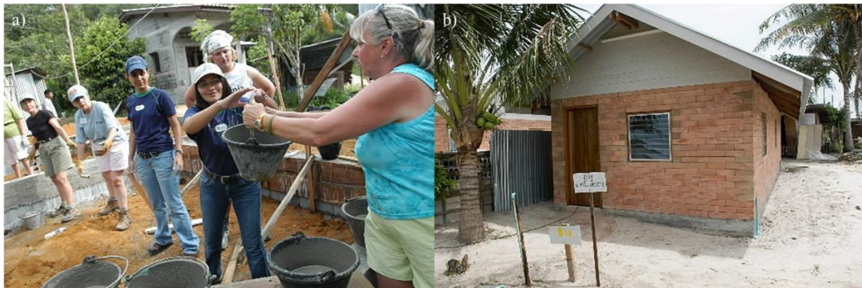
Abb. 3.47: Wiederaufbau eines Wohnhauses in Thailand (Internetquelle 43)
