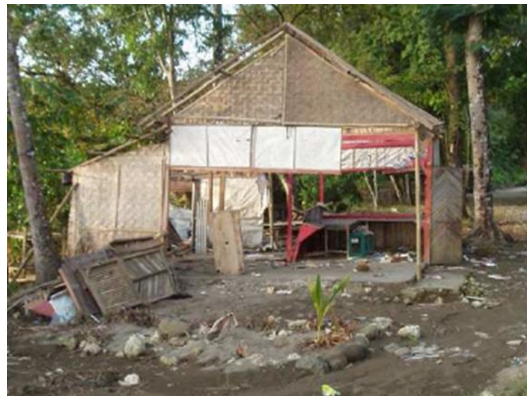
Abb. 5.3: Zerstörung eines Wohngebäudes aus Bambus auf Java, Indonesien (Reese, et al., 2007)
