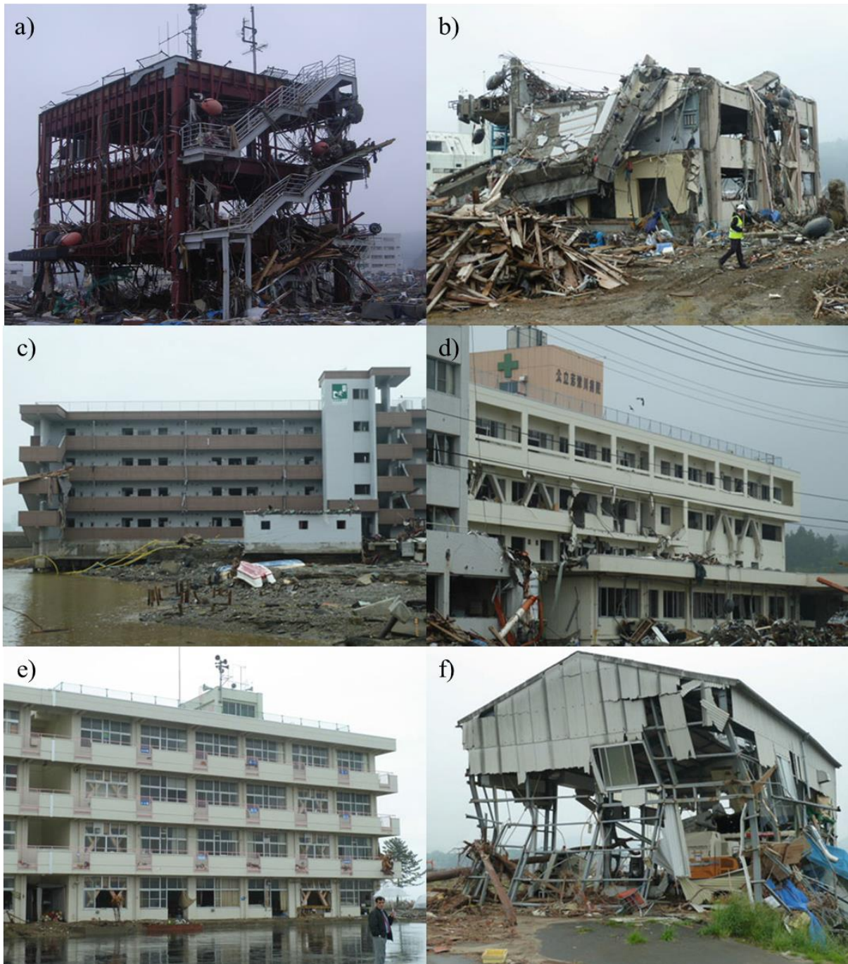
Abb. 5.8: Stahlbetongebäude in Japan, die dem Tsunami standgehalten haben (Fraser, et al., 2012): a) 3-geschossiges Stahlgebäude des Crisis Management Departments, b) Stahlbetongebäude in Shiomi-cho in Minami-Sanriku, c) Matsubara Apartment und Evakuierungsgebäude in Minami-Sanriku, d) Shizugawa Krankenhaus in Minami-Sanriku, e) Grundschule und Evakuierungsgebäude in Arahama, f) Stahlgebäude in Yamamoto
