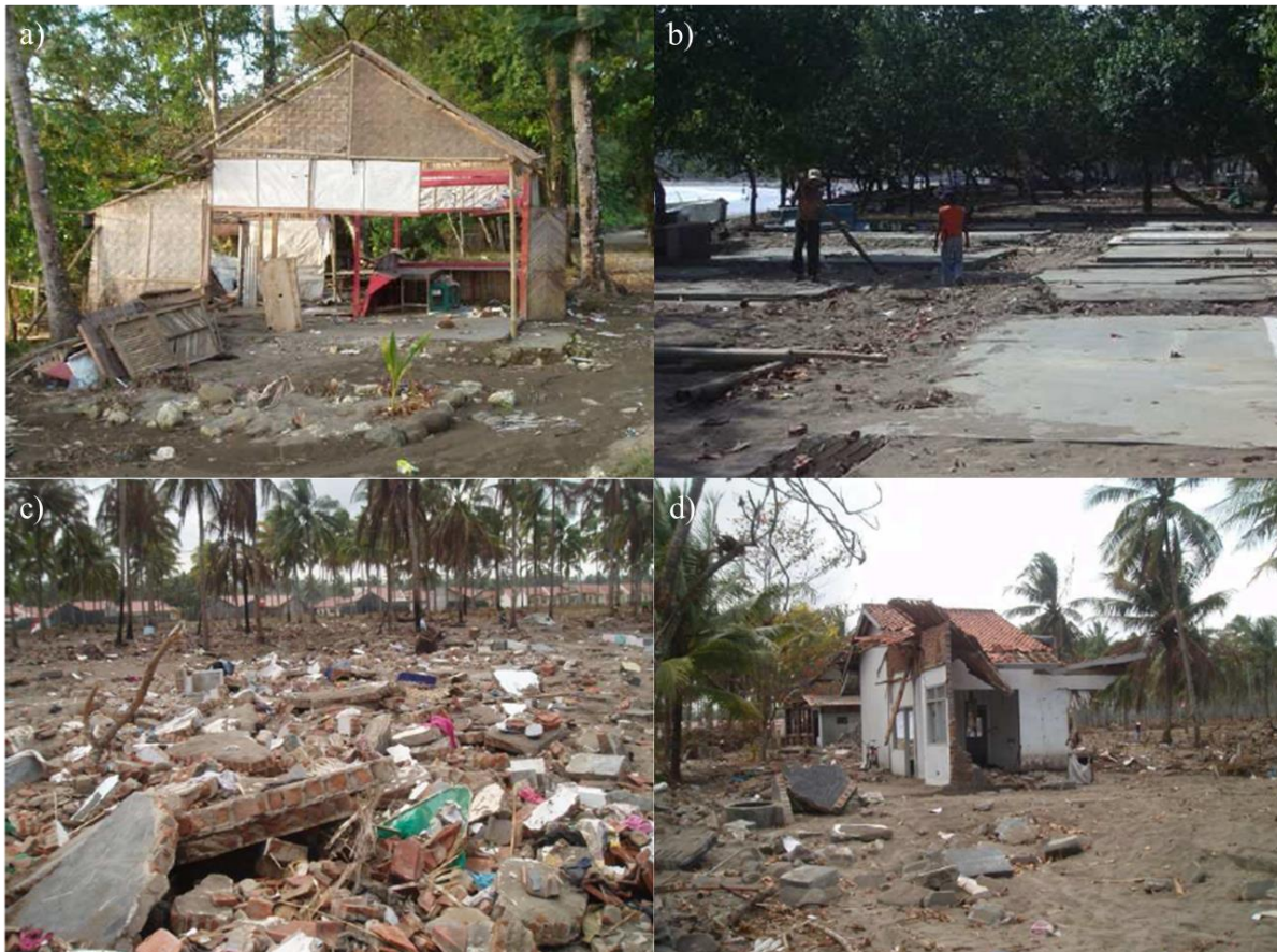
Abb. 3.13: Landestypische Leichtbauweisen auf Java, Indonesien (Reese, et al., 2007): a) und b) Zerstörung bei Bambus-Holzhausern nach Überflutungshöhen von 1 m bzw. 3 m, c) und d) traditionelle Ziegelsteinbauten bei Überflutungshöhen von ca. 3 m
