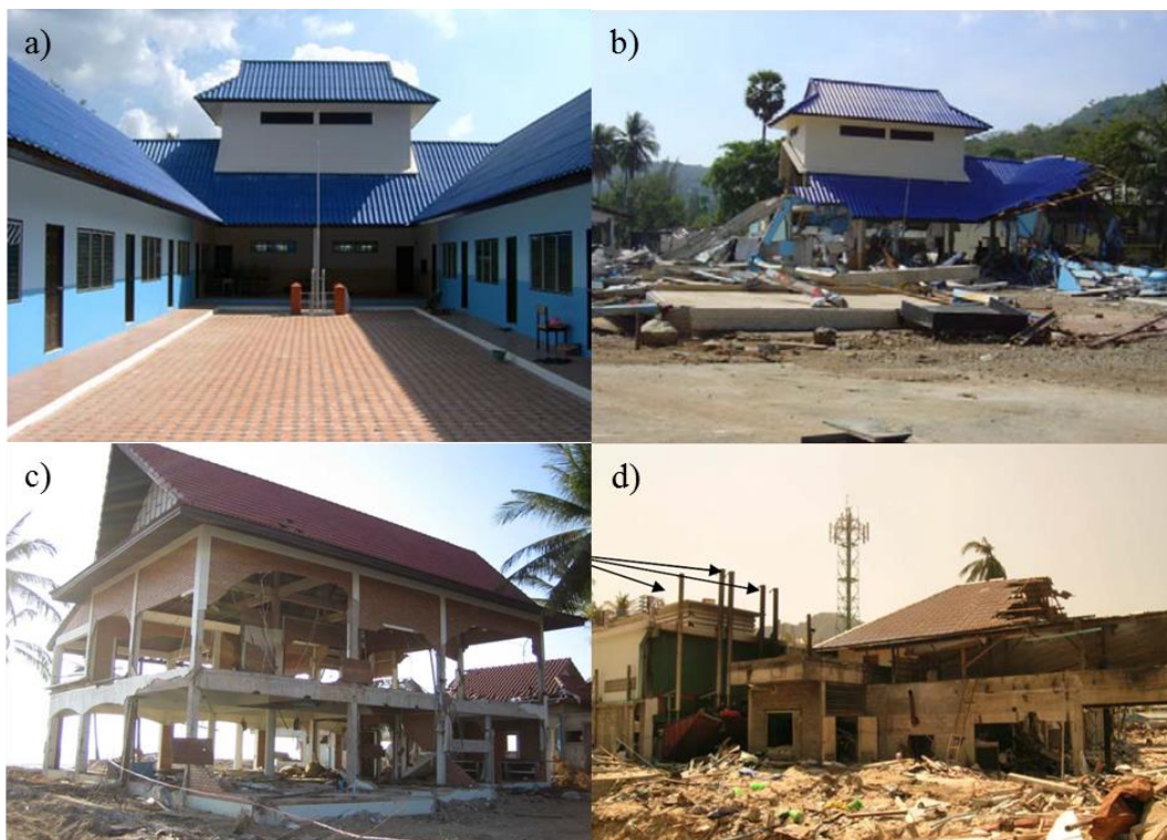
Abb. 3.20: Öffentliche Gebäude bzw. mögliche Evakuierungsgebäude in Thailand (Pomonis, et al., 2006): a) und b) Schule in Kamala Beach vor und nach dem Tsunami, c) 2-etagiger Resort in Khao Lak, d) örtliches Elektrizitätswerk und Kommunikationsgebäude in Phi Phi Island
