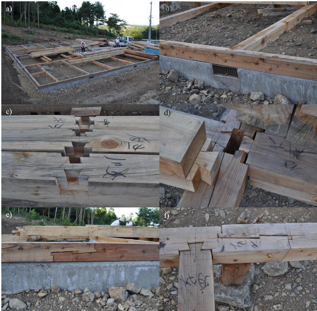
Abb. 3.2: Hausbau bei Miyako, Japan: a) Betonfundament mit Holzunterkonstruktion, b) Fundament mit Lüftungsgitter, c) und d) durch Nut verbundene Holzbalken
