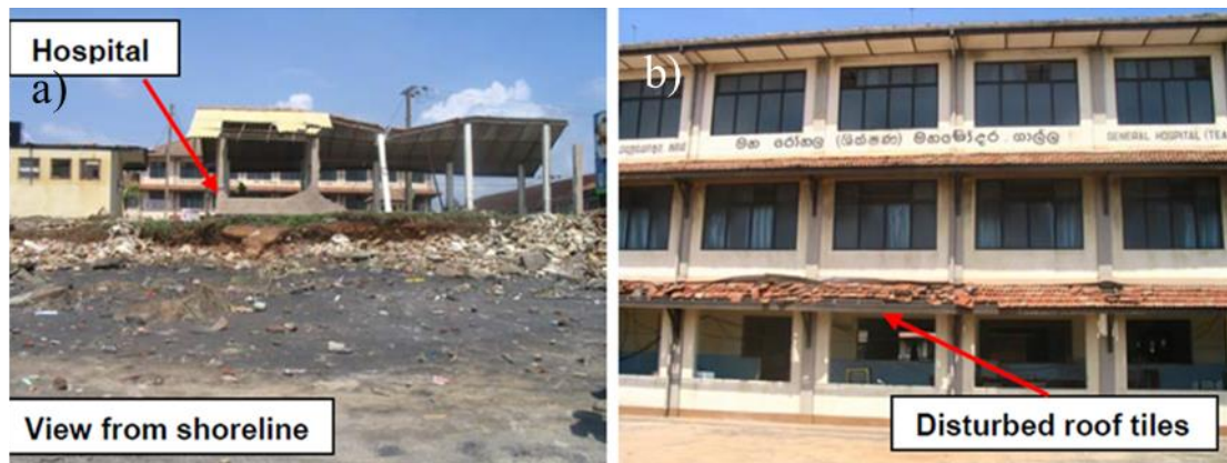
Abb. 5.9: Krankenhaus in Galle, Sri Lanka, erlitt lediglich mäßige Schäden (Pomonis, et al., 2006)
