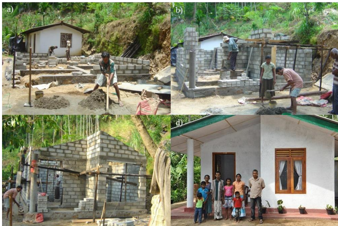
Abb. 3.4: Bauschritte eines traditionellen Ziegelsteinhauses in Sri Lanka (Internetquelle 17)
