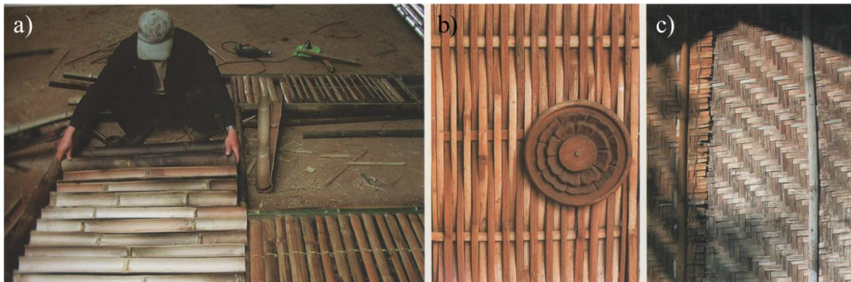
Abb. 3.10: Traditionelle Baustoffe in Thailand (Sthapitanonda & Mertens, 2006): a), b) und c) geteilter Bambus, Rattan und Schilf als Leichtbauwand
