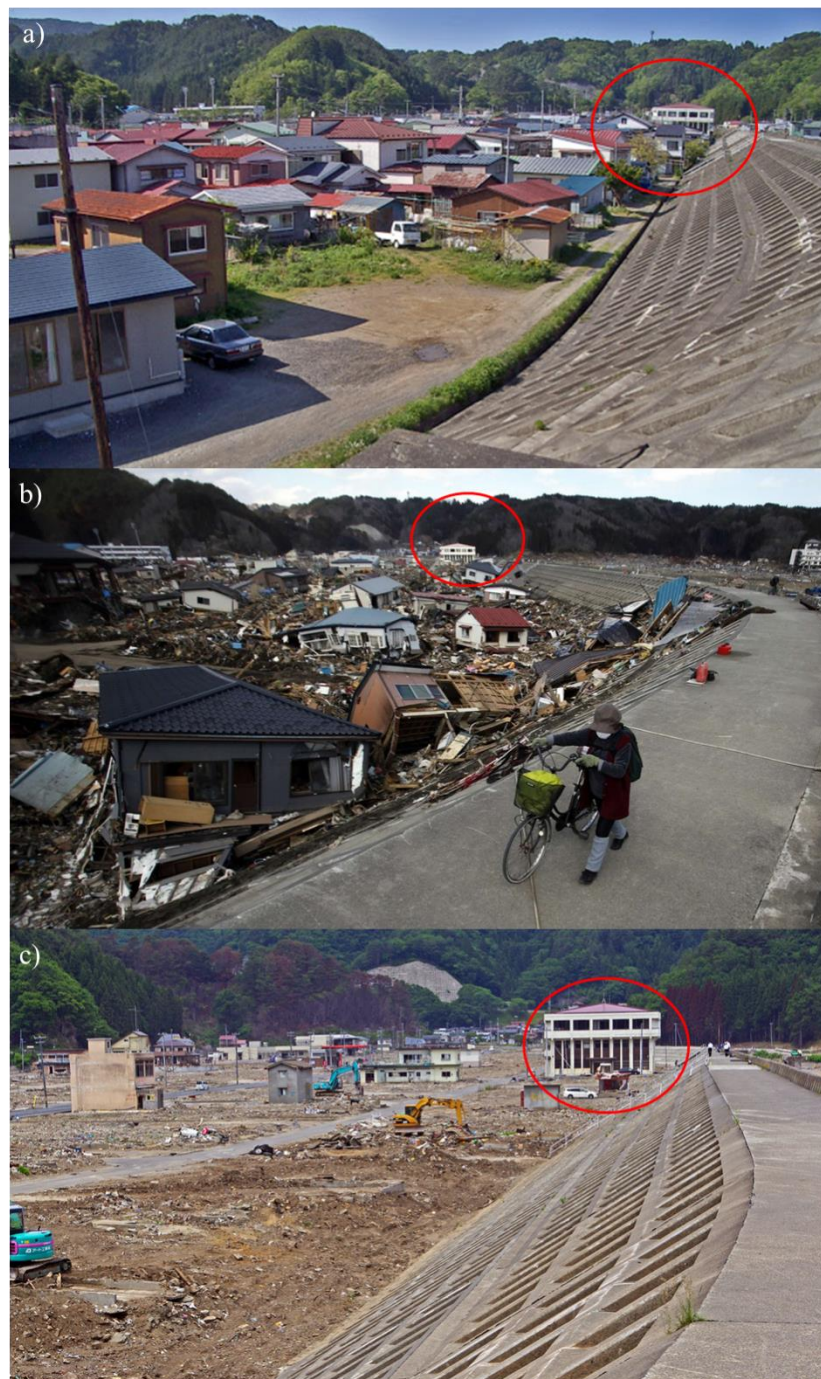
Abb. 5.2: Wohngebiet in Taro, Iwate in Japan: a) vor dem Tsunami von 2011 (Internetquelle 54), b) unmittelbar nach dem Tsunami 2011 (Internetquelle 55), c) nach Beseitigung von Schutt (Internetquelle 56)
