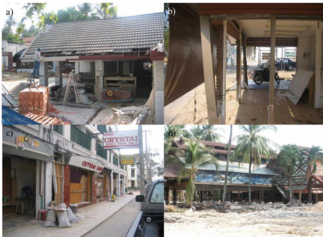
Abb. 5.4: Zerstörung von 1-geschossigen Holzgebäuden in Thailand (Saatcioglu, et al., 2005): a) und b) Kata Beach, c) und d) Patong Beach
