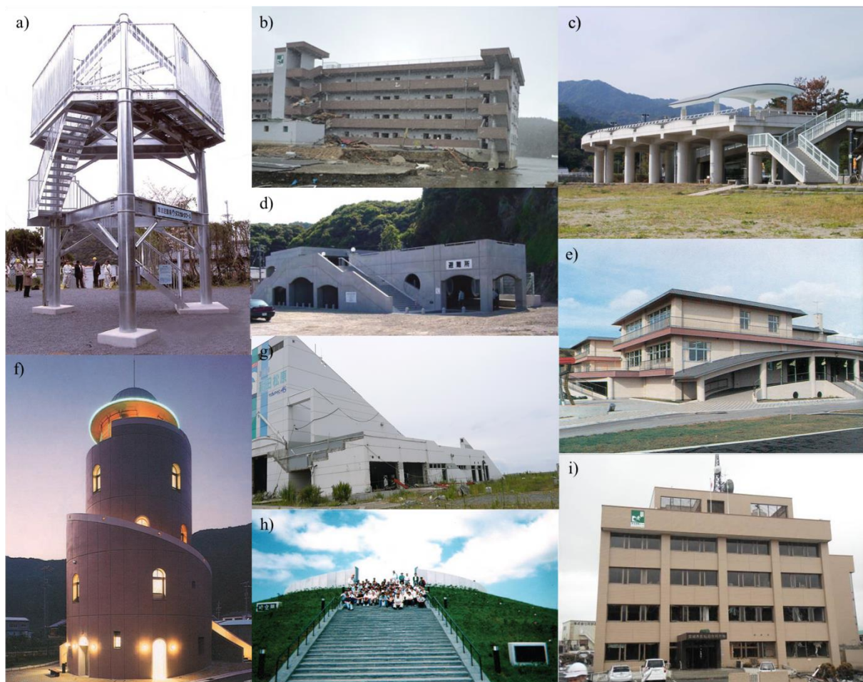
Abb. 3.16: vertikale Evakuierkonstruktionen in Japan: a) Life-Saving Tower/Tasukaru Tower in Tanabe Town (FEMA-P646, 2008), b) Gebäude in Minamisanriku nach 2011 (Shibayama, et al., 2013), c) Shirahama Beach Resort in Toyo (FEMA-P646, 2008), d) Gebäude in Kaifu (FEMA-P646, 2008), e) Grundschule in Aonae f) Nishiki Tower (FEMA-P646, 2008), g) Konstruktion in Rikuzentakata nach 2011 (Dank an Gesa Neuert), h) Berme in Aonae (FEMA-P646, 2008), i) Gebäude in Kesenuma City (Internetquelle 29)
