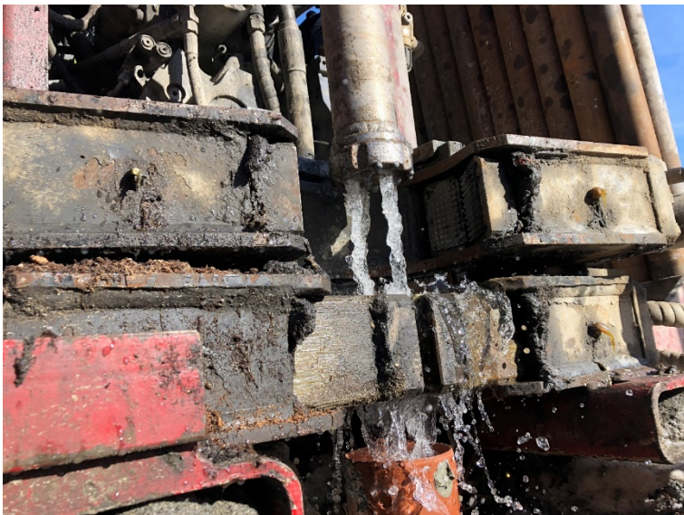
Figur 21 Bilet av ringbit med spylinga på. Frå installasjon av SW6.
