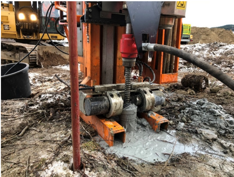
Figur 10 Installasjon av saltbrønn med bortårn. Borstrengen er påmontert eit adapter (raudt) for tilførsel av salt for å unngå at saltet går gjennom pumpa på riggen.
