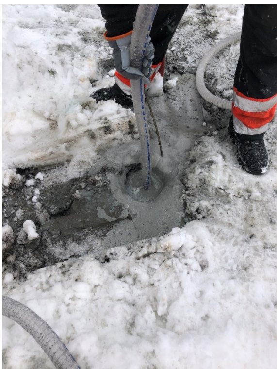
Figur 14 KCl-slurry blei pumpa ned i borholet via ein armert slange med diameter 32 mm.
